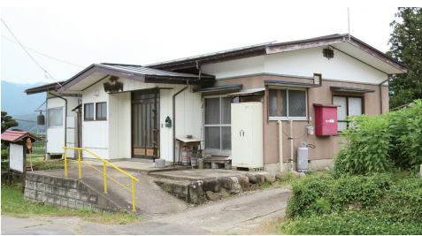
屋根を改修した荒砥新町分館
