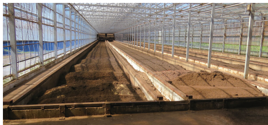
堆肥センター
