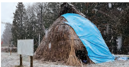
惜しまれつつ解体
