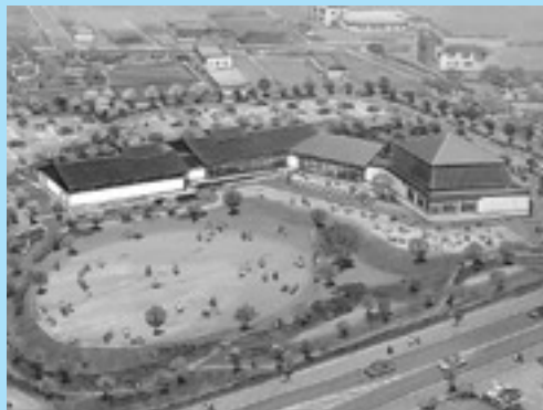
平成20年度までの2カ年に及ぶ文化交流センター本体の建設が始まります。 (鮎貝まちづくり拠点施設整備事業)
