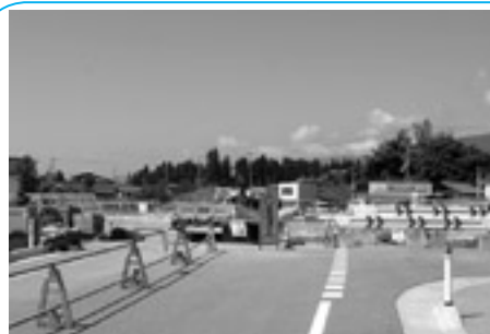
▲建設の進む「八幡沢橋」。完成後は、新しい流れができます。
