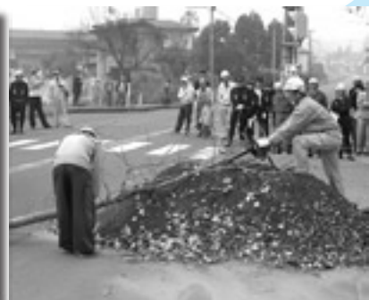
商工会建木部会の道路障害除去訓練
