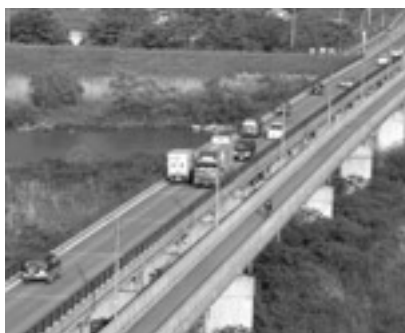
▲早期整備が期待される荒砥橋
