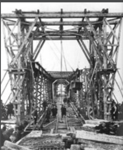
▲最上川橋梁工事 1922(大正11)年
