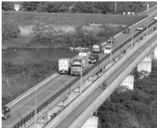
早期整備が期待される荒砥橋▶
