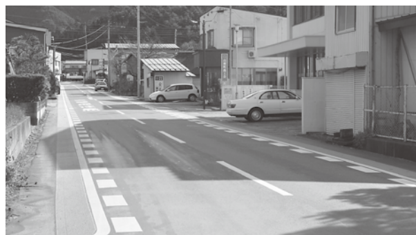
改修された役場東側の道路 （交差点照明も設置されました）
