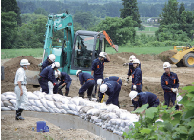
▲7月20日、消防団による土のう積み上げ作業（山口）。
