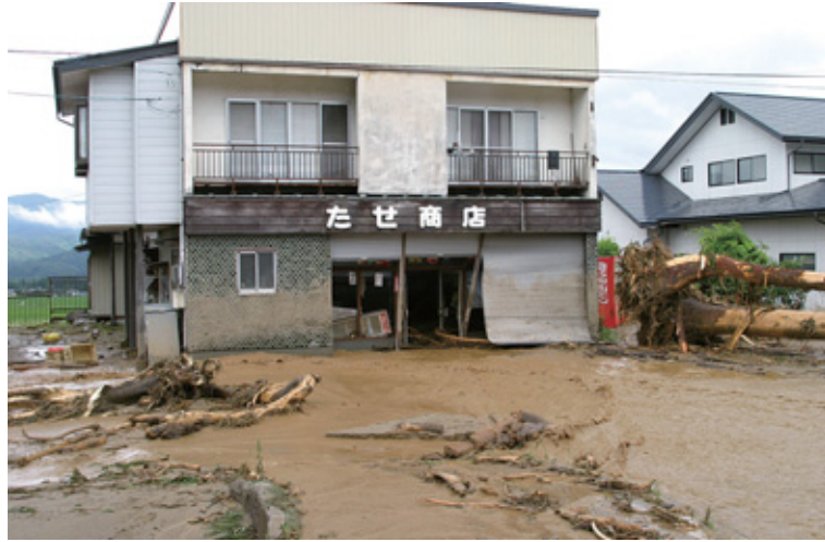
▲泥水とともに大量の木が流され建物内にも押し寄せた（西高玉）。
