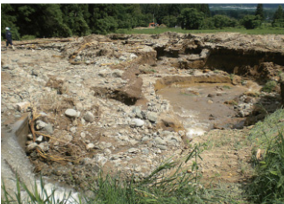
▲農業用水路が氾濫、あふれ出た水によって大きくえぐられた牧草地（山口）。
