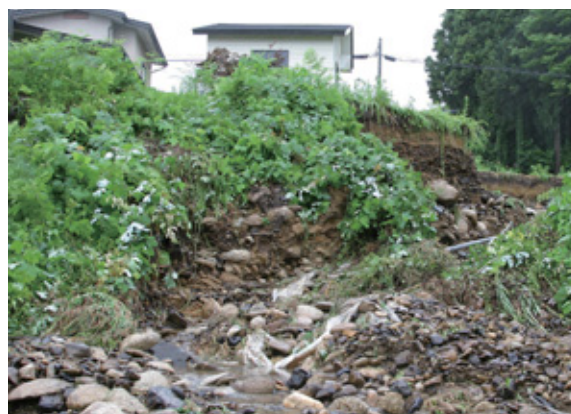
▲畑が崩れてすぐ脇の建物にも危険が迫った（深山）。崩れた土砂が町道橋本新田線をふさぎ一時通行止めに。
