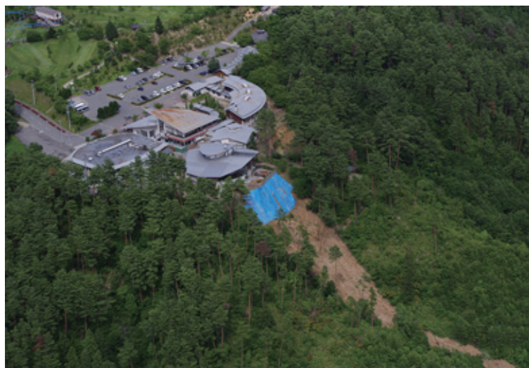
▲町民保養センターパレス松風裏の土砂崩れ。
