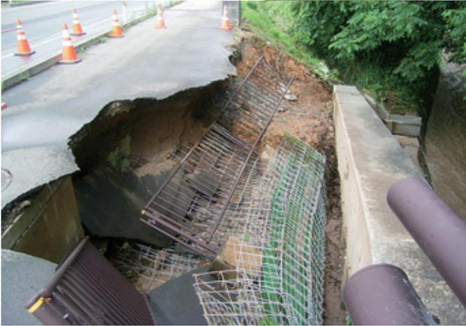
▲国道348号線（十王）。斜面の土が崩れ歩道の路面も大きく損壊した。
