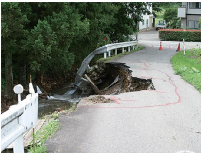
▲町道中滝野線（滝野）。ガードレールごと大きく崩落し通行不可となる。
