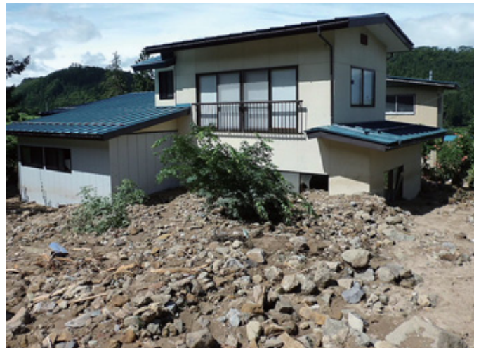
▲土石流が流れ込み1階部分が埋まる（貝生）。
