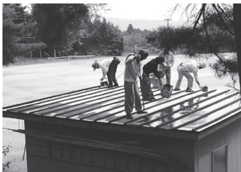
▲鮎貝小学校体育小屋のペンキ塗りかえ作業
