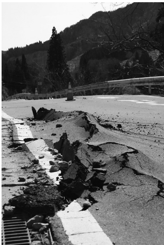
▲地滑りが原因で路面に隆起や亀裂が発生している国道287号。復旧のめどは立っていない。
