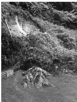
▲昨年7月の峰岸地区の土砂崩落
