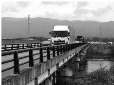
▲老朽化も進み、早期の整備が望まれる荒砥橋
