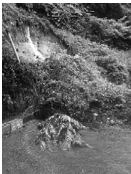
▲昨年7月の峰岸地区の土砂崩落
