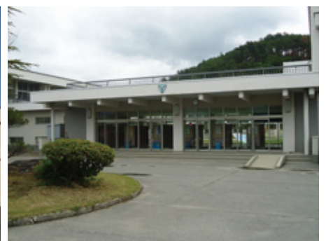
昇降口外観（着工前）
