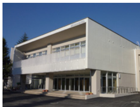
昇降口外観（完成）
