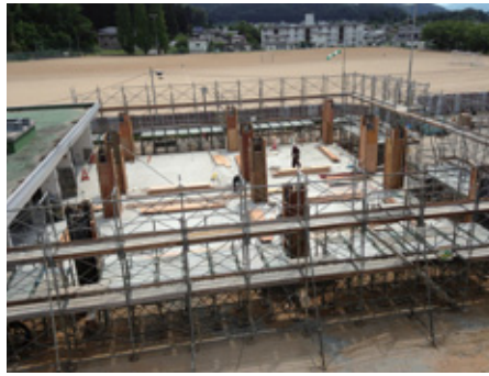
管理棟（2階より）
