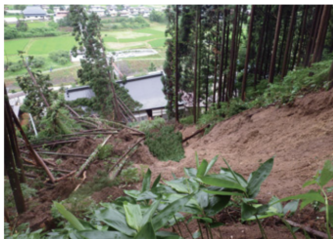
▲円光寺裏の土砂崩れ
