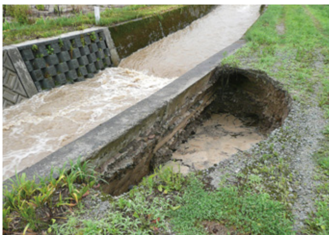
▲町道下夕町慶海壇線（横田尻地区）
