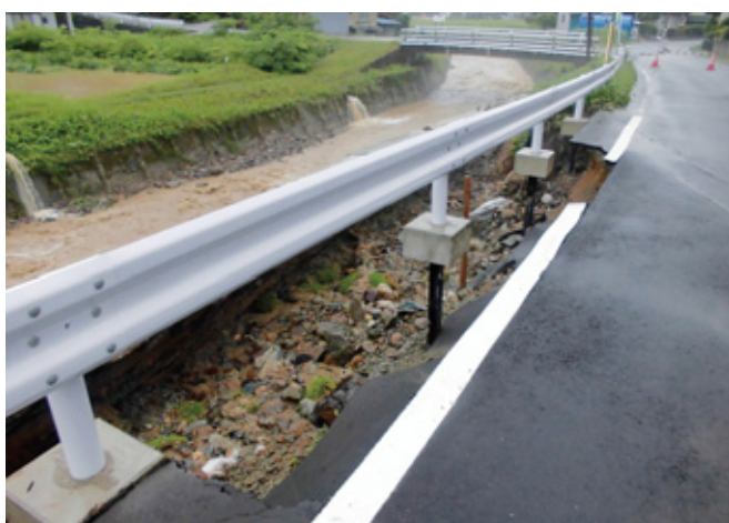
▲町道貝生線（貝生地区）
