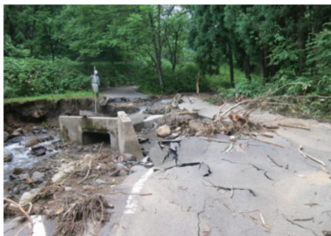
▲林道小野ヶ入線 (畔藤地区)
