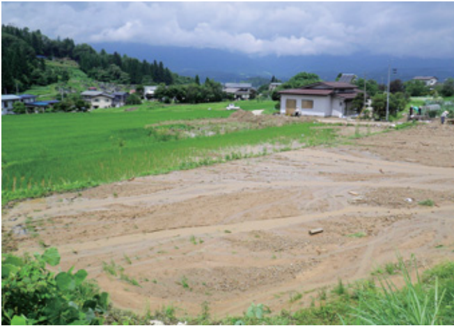
▲一面に土砂が流入した水田。(貝生地区)
