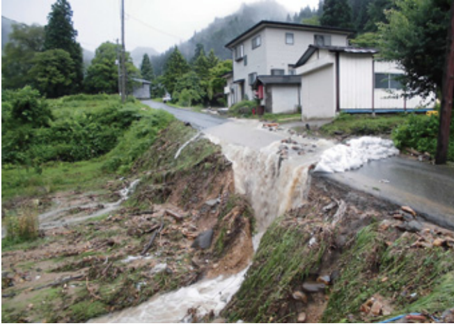
▲町道上杉沢線（畔藤杉沢地区）
