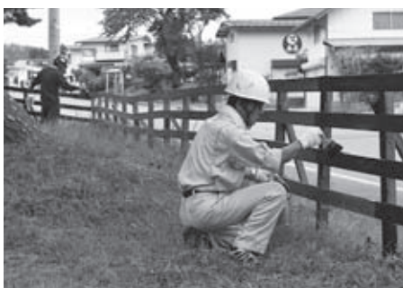
▲鮎貝小学校での外柵のペンキ塗装作業。
