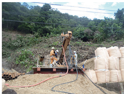
▲グラウンドアンカー施工状況
