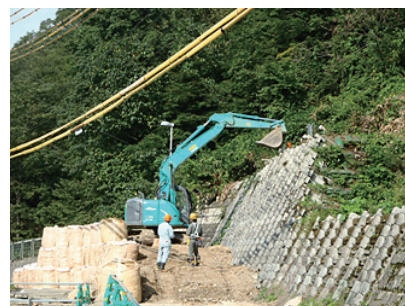
▲山側の井桁擁壁撤去
