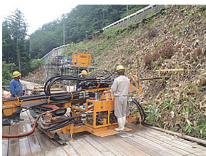
▲横ボーリング削孔状況
