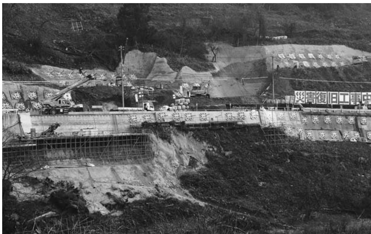
早期の復旧に向け工事が進められている大瀬地内の国道287号。(最上川対岸より)
