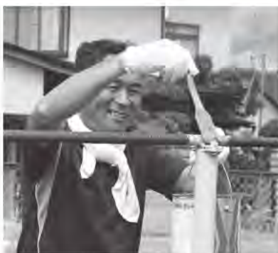
▲蚕桑小学校の遊具の塗装
