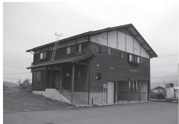
入居を募集する施設(Aタイプ)の外観
