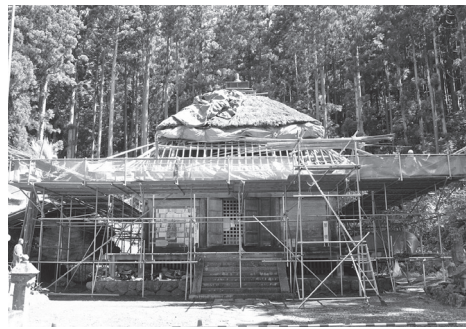
工事中の観音寺観音堂(深山観音)
