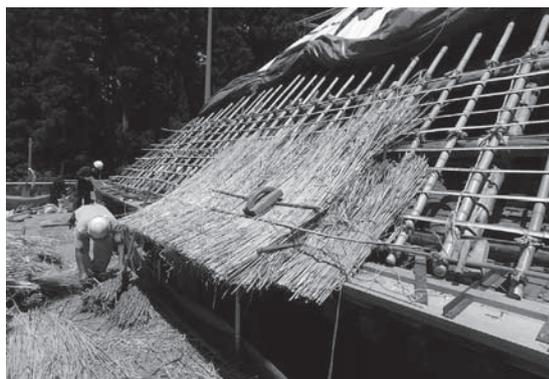
伝統的な技法で茅葺屋根の葺き替え作業が行われた
