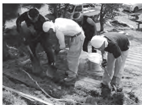
蚕桑小学校グラウンドにある滑り台の枕木を整備する建設組合員
