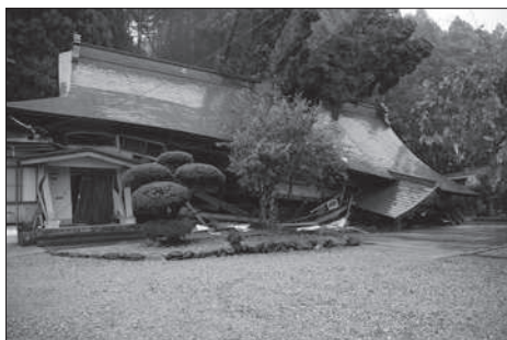
平成26年に発生した集中豪雨により十王地内で土砂崩れが発生。円光寺が倒壊した。
