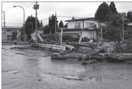
平成25年に発生した集中豪雨により西高玉地内の住宅地に土砂が押し寄せた。
