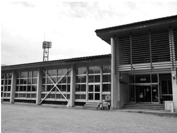
整備が望まれる 就業構造改善センター
