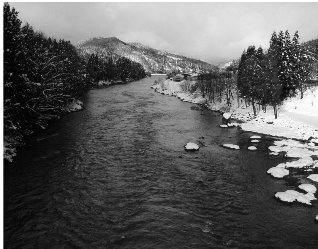
実証された舟道「黒滝開削跡」
