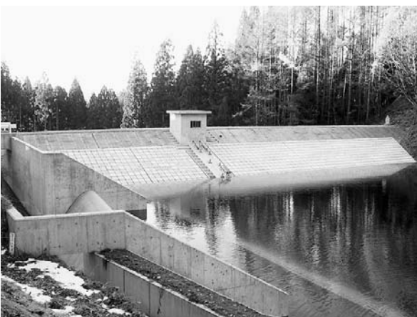
完成した原虚空蔵ため池(中山地区)
