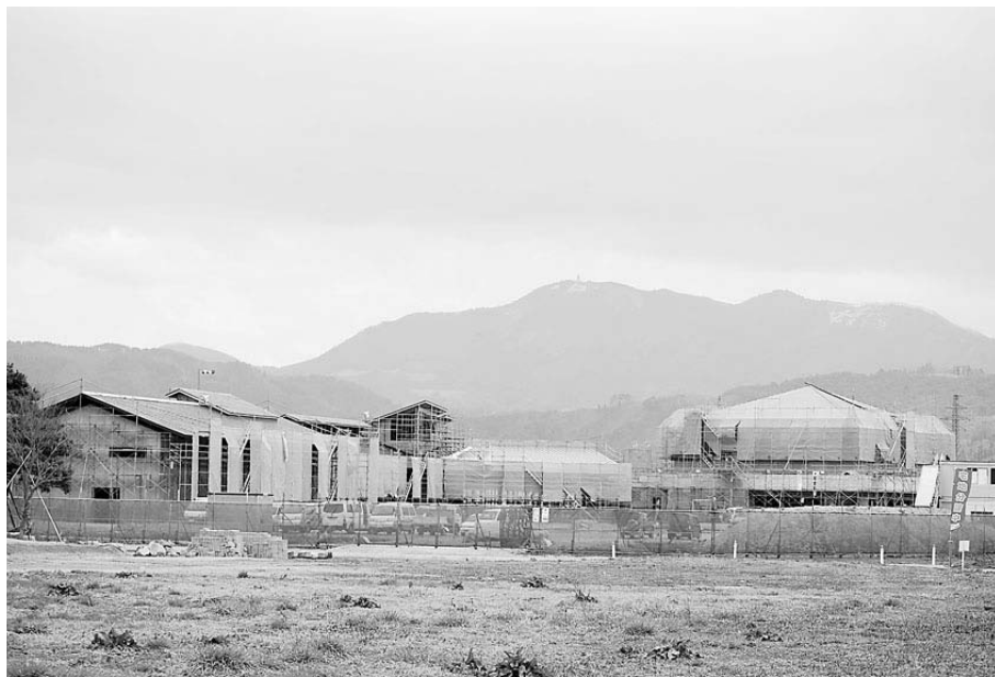
工事がすすむ文化交流センター
