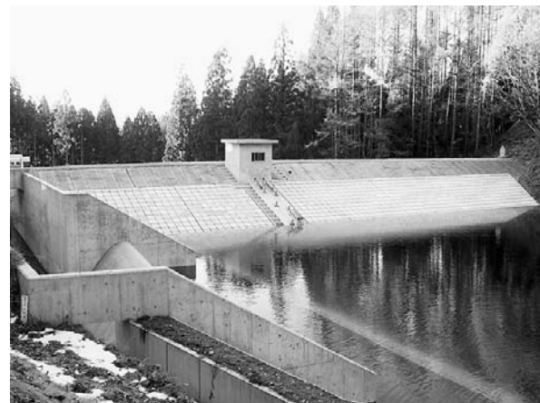
完成した原虚空蔵ため池（中山地区）
