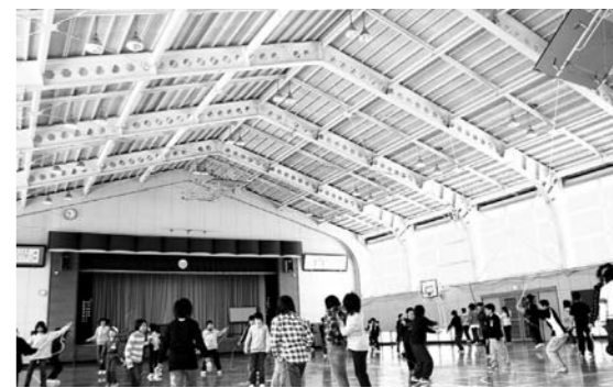
蚕桑小学校 体育館
