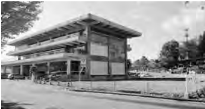
大ホールが解体された中央公民館
