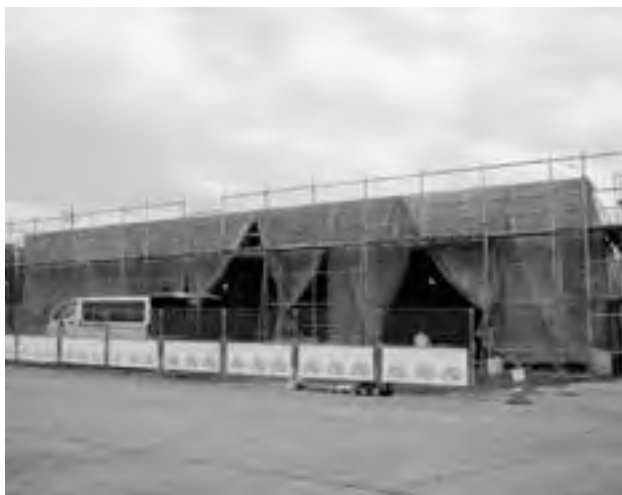
建設中のスクールバス車庫
