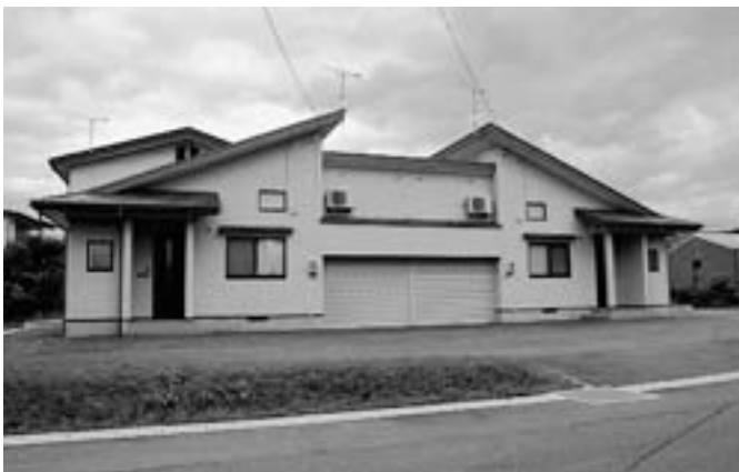
医師確保に期待 医師住宅 (元荒砥駐在所跡)
