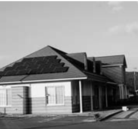
太陽光発電（荒砥・八幡二公民館）
