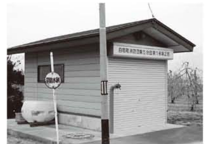
防火水槽(町下地区)
