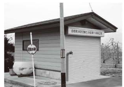
防火水槽(町下地区)
