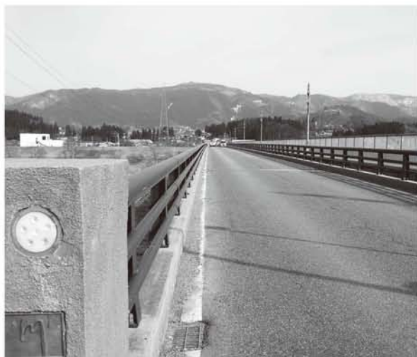
西側から望む荒砥橋
