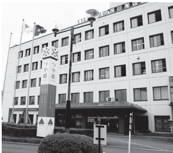
置賜総合支庁西庁舎（長井市）
