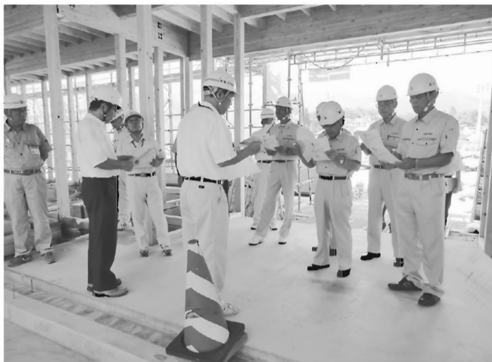
現地調査（子育て支援拠点施設）
