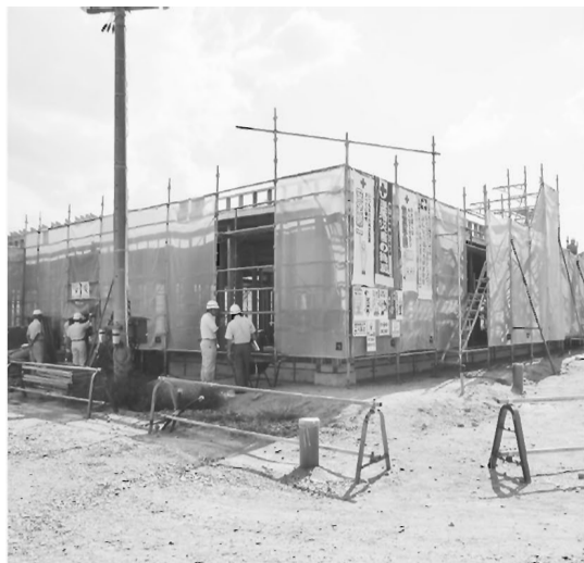
急ピッチで建設がすすむ子育て支援拠点施設 (鮎貝・四季の郷)
