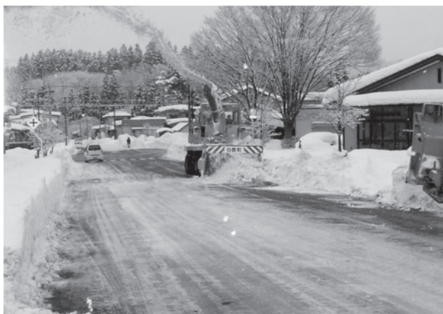
除雪作業風景
